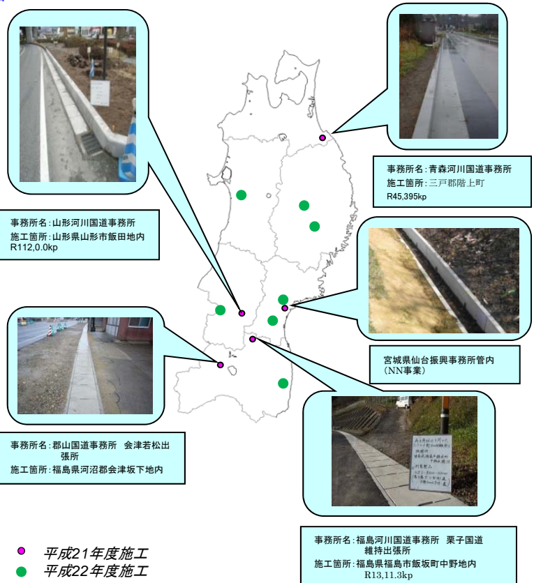
再生骨材コンクリート製品敷設現場
